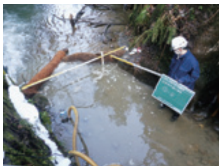
濁水処理対策①
