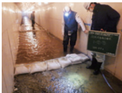
濁水処理対策②
