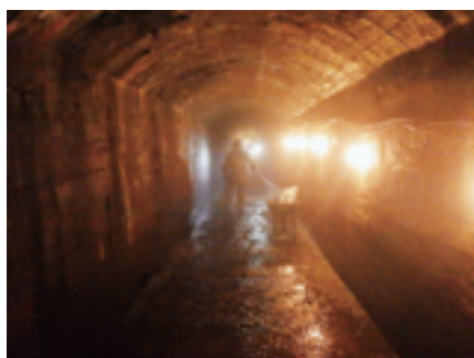
高圧洗浄状況
