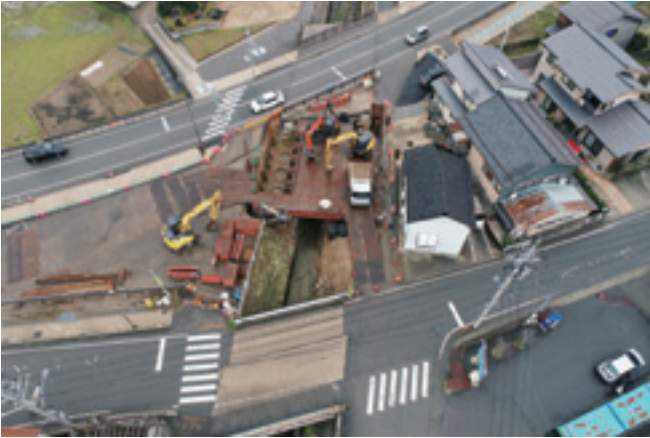
仮設構台設置
