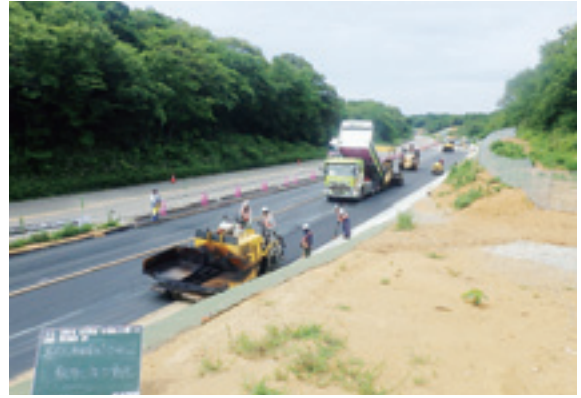
新設 舗装敷均し状況
