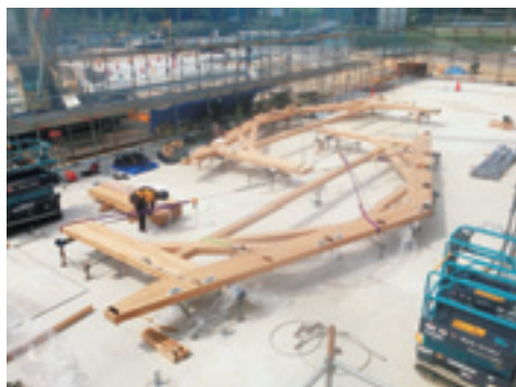
木軸地組状況
