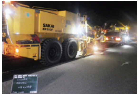
既設 路面切削状況
