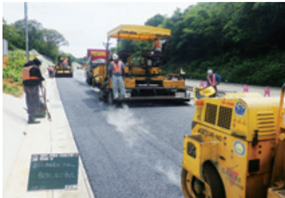
新設 舗装敷均し状況
