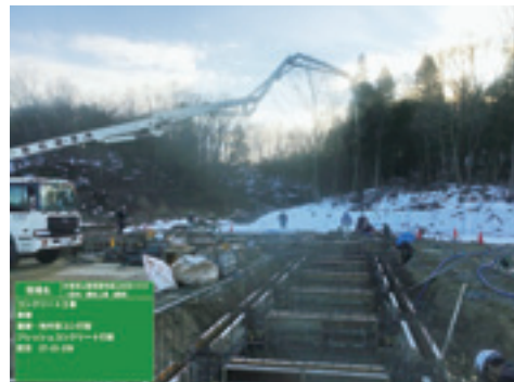
基礎コンクリート打設状況
