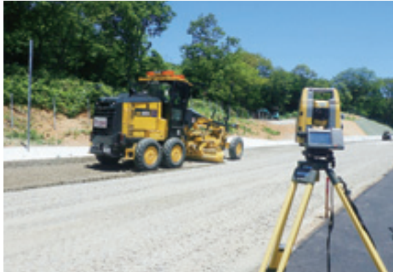
新設 路盤敷均し状況 (マシンコントロール)
