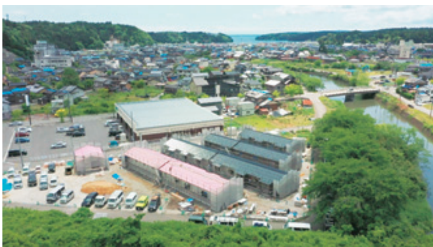
穴水町で建設中の木造仮設住宅
