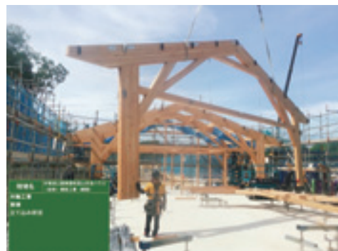
木軸立て方状況
