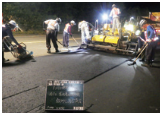
既設 舗装敷均し状況
