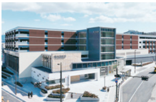
写真-5 完成した兼六駐車場
