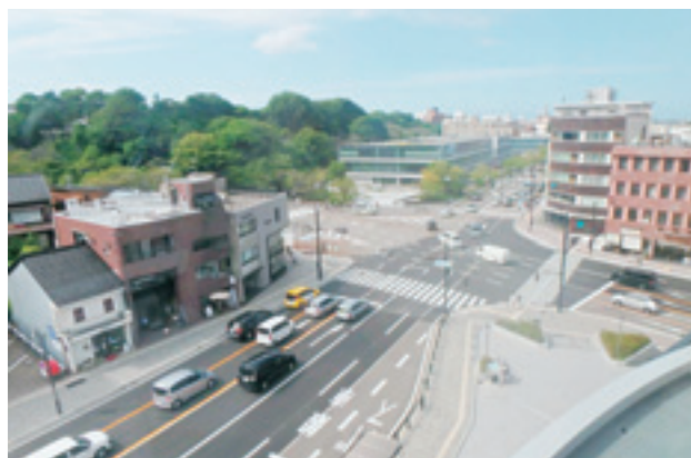
写真-6 完成した兼六園下交差点
