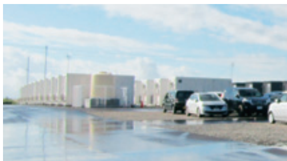
のと里山空港仮設宿泊所
