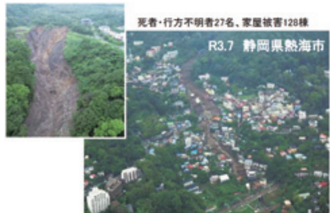
写真-1 静岡県熱海市の土石流災害
