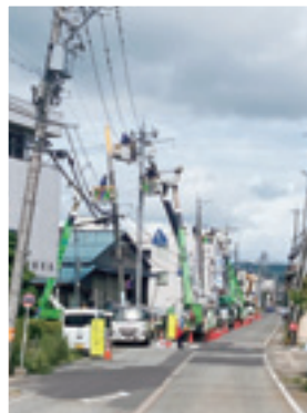
江田慈子「電柱工事」
