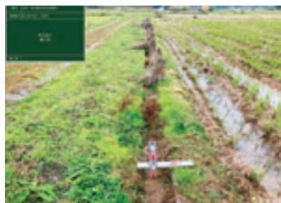
土砂流入による排水路埋没
