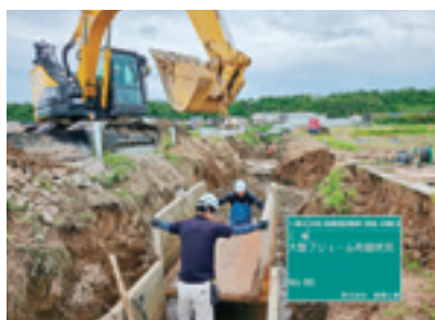
復旧工事状況
