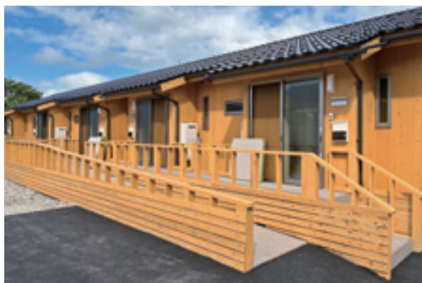
写真3 上戸町第3団地（珠洲市）
