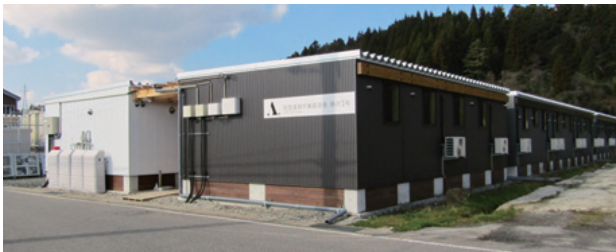
施設外観 (南東側から撮影)
