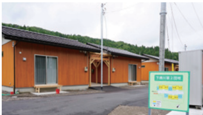
写真4 下唐川第2団地（穴水町）
