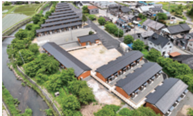
写真2 三井町第1団地（輪島市）
