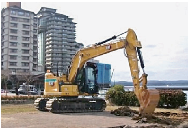
写真-3 港湾区域内の施工状況（国代行）
